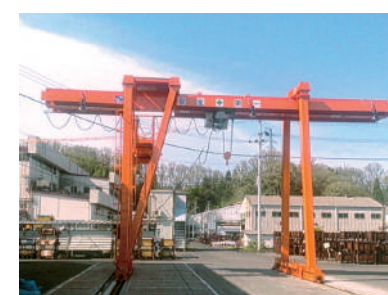
7.5t×SP7.0m橋形クレーン
