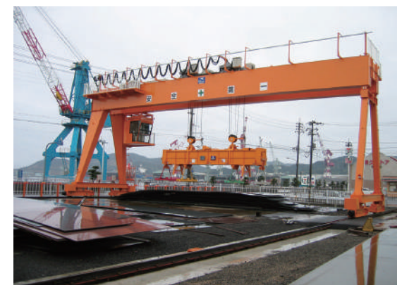
運転室付橋形クレーン
