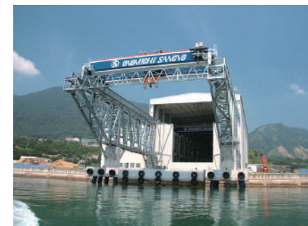
105t+105t/15t 天井クレーン
