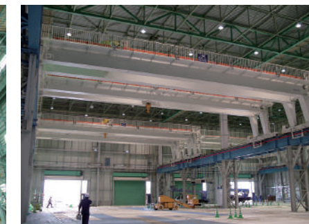
建屋に負担をかけない脚付天井クレーン
